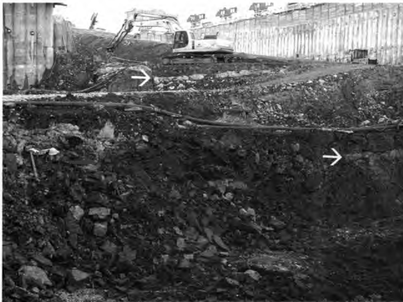
Abb.1: Baustelle „Westhafen“, hier Baugrube Westhafen-Tower, Anfang August 2001. Als helle Bänder (mit Pfeilen gekennzeichnet) sind 2 Kalkbänke zu sehen, die ein Gefälle von 8 % aufweisen.
