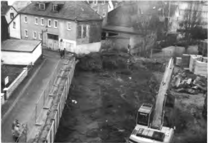
Abb. 1: Blick auf die Baustelle Wallstraße 38-40 vom Steinheimer Torturm aus. Der mittelalterliche Stadtgraben zeichnet sich deutlich als graue Verfärbung ab.
