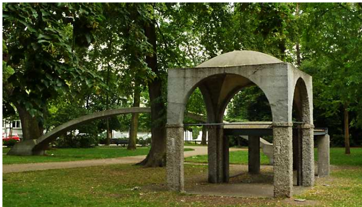
Ein Teil des 1879 als erster Offenbacher Park entstandenen Dreieichparks mit den ältesten erhaltenen Betonbauten ohne Stahlbewehrung in Deutschland
