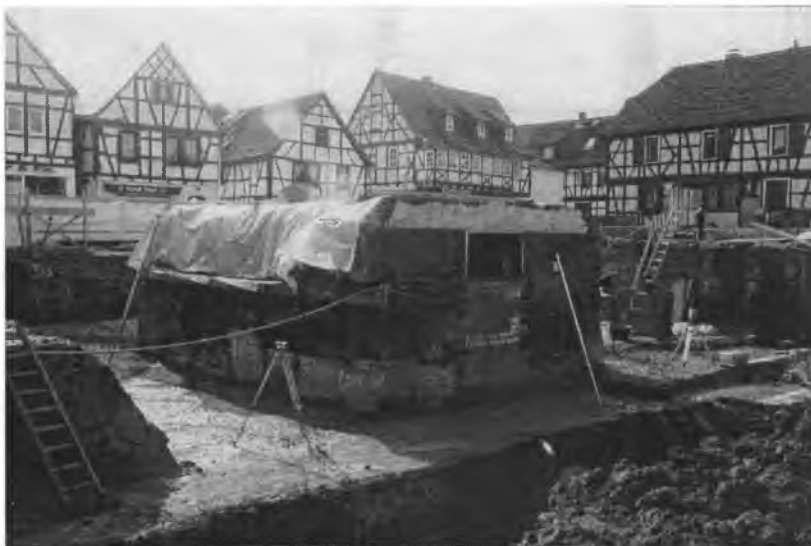
Abb. 2: Der in der Baugrube frei stehende Gewölbekeller D; Blick zur Fahr-gasse. Foto: Gesine Weber (UDSchB).
