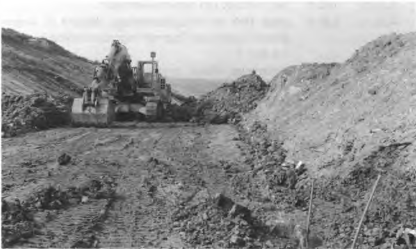
Abb. 1 (oben): Baustelle B 3a, August 1986. Untere Bildkante etwa 150 m nördlich der Brücke. Sammler auf der Hauptbarschlage stehend.
